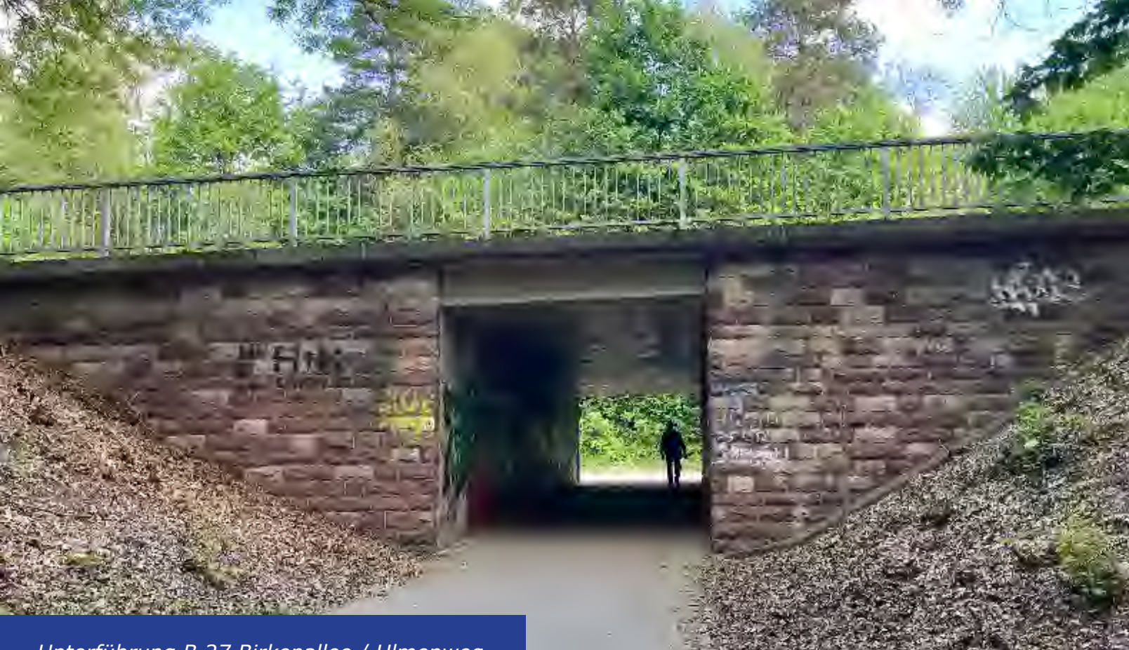
Unterführung B 27 Birkenallee / Ulmenweg
