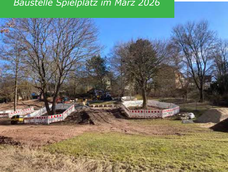
Baustelle Spielplatz im März 2026
