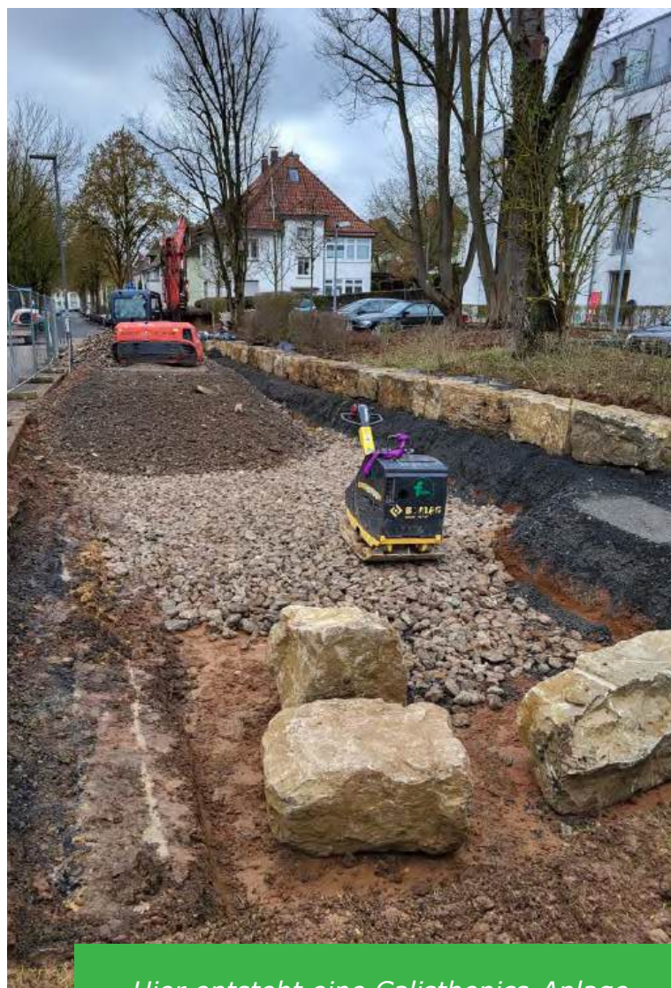
Hier entsteht eine Calisthenics-Anlage
