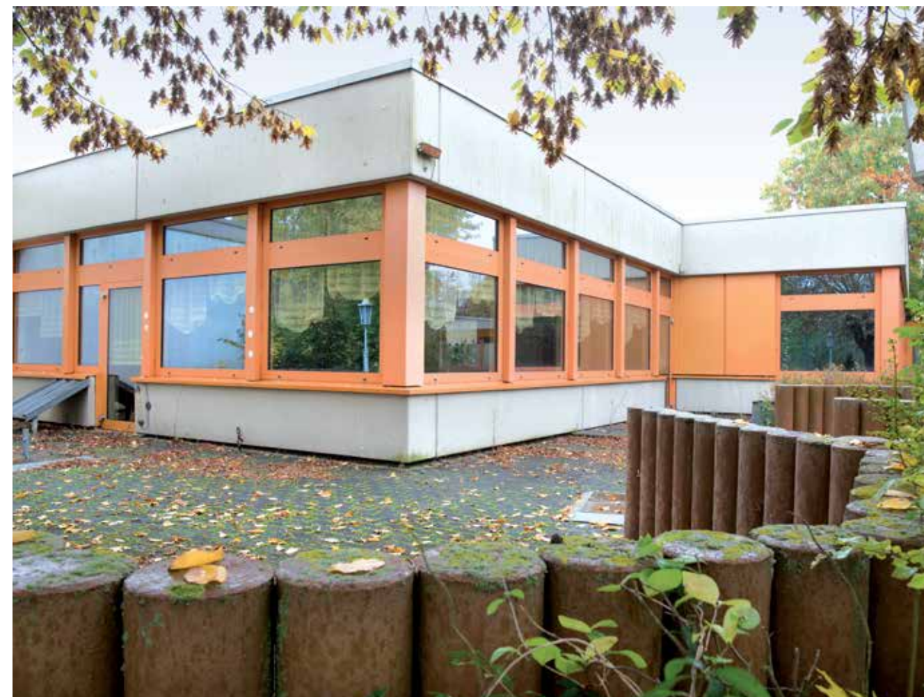
Zu ersetzendes Haus der Begegnung
