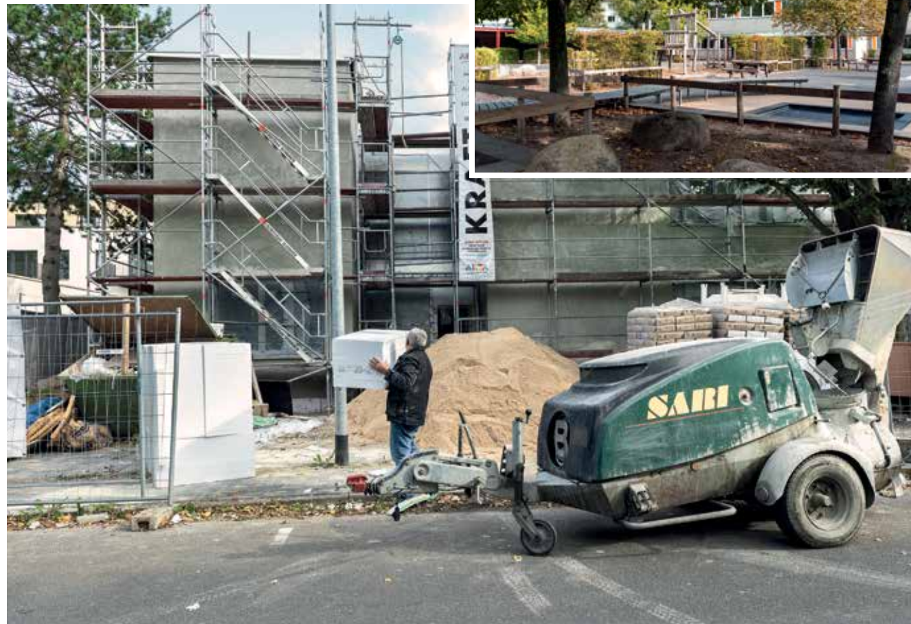
Neubau Stadtteilzentrum (Baustelle)
