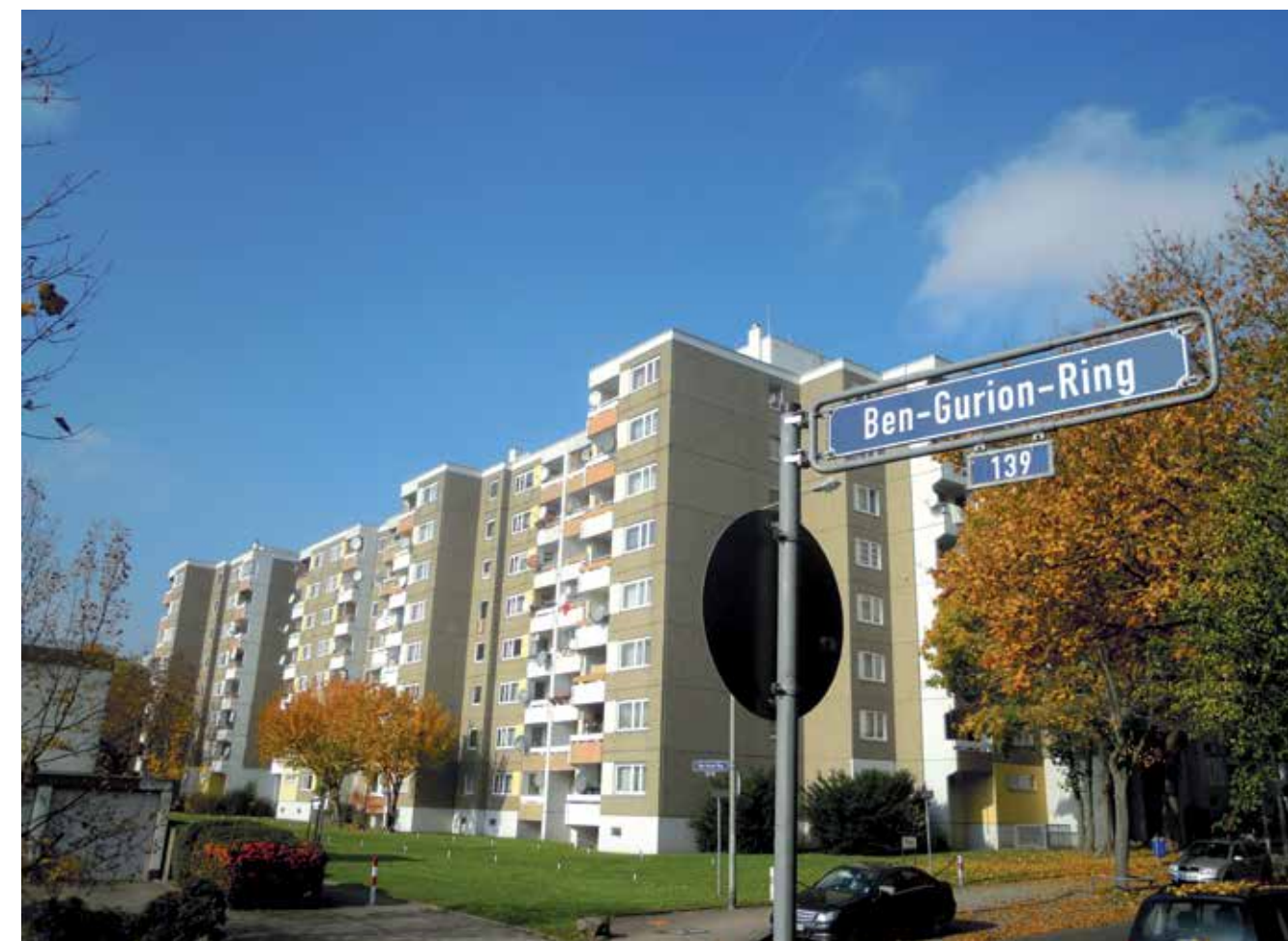
Großwohnsiedlung der 70er Jahre am Stadtrand
