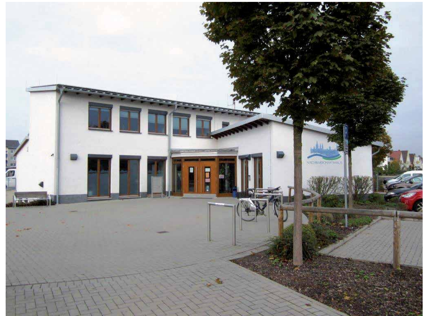
Neu gebautes Nachbarschaftshaus
