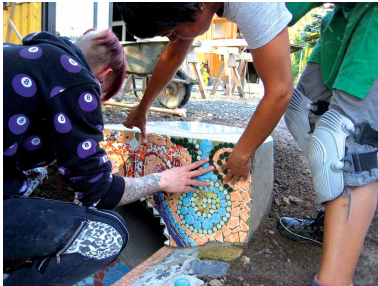
Über Arbeitsmaßnahmen gestaltete Brunnenanlage im Kunstpark Himmelfels
