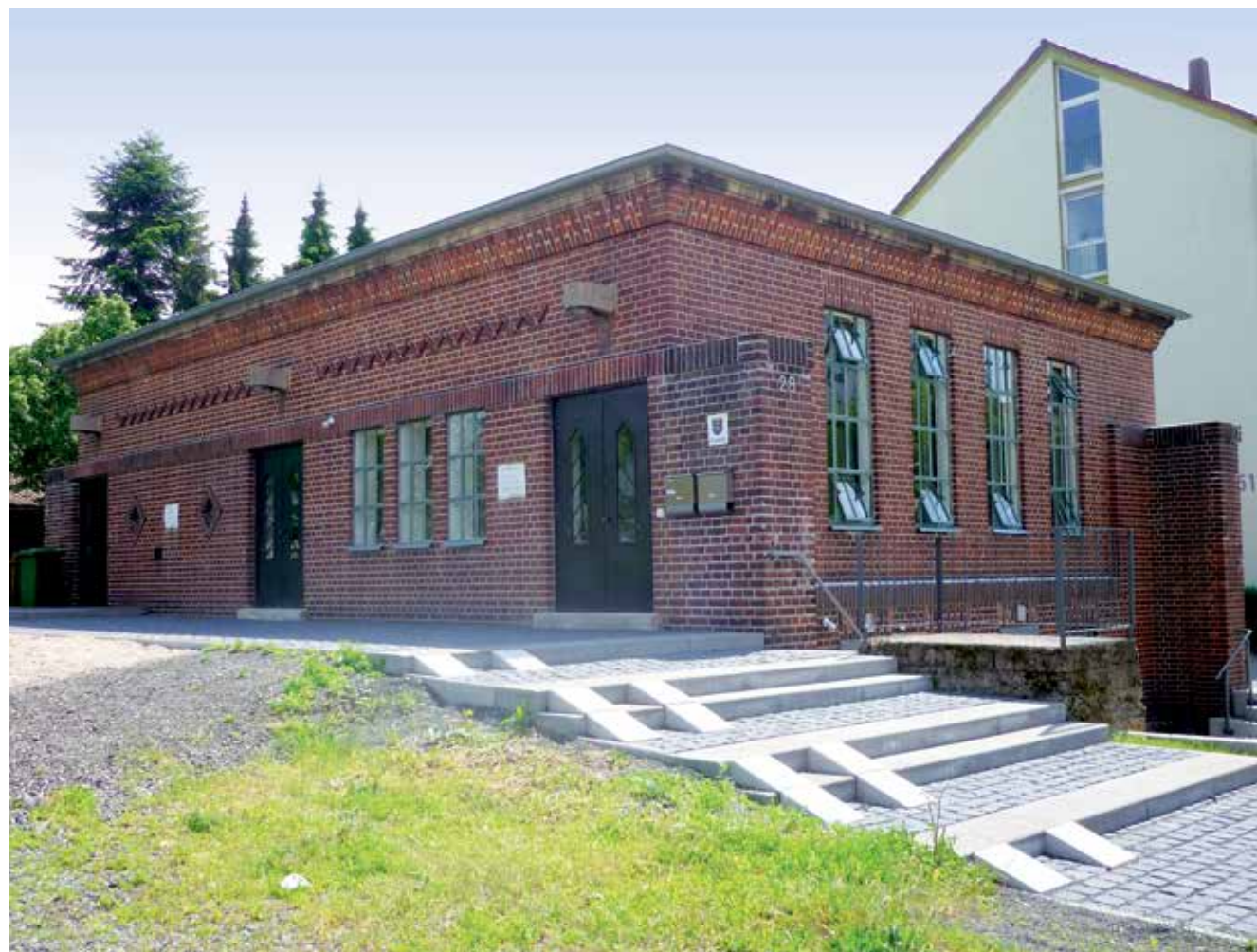
Quartiers- und Vereinszentrum im ehemaligen Transformatorenhaus
